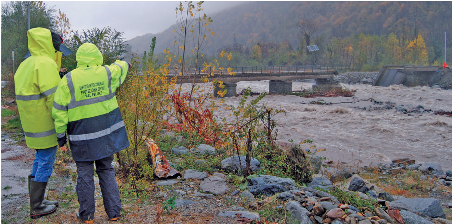
TORRE PELLICE - Il ponte della Bertenga ha ceduto anche questa volta. E 98 persone, nell'inverso, sono rimaste isolate. (Foto G. Falco)
